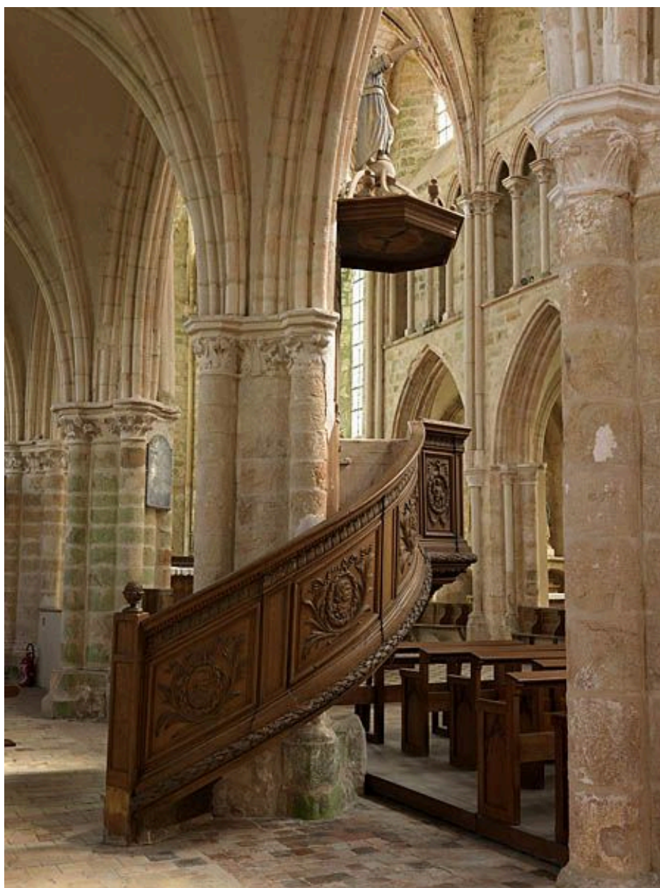
Vue d'ensemble, depuis le nord-ouest (collatéral nord de la nef).
