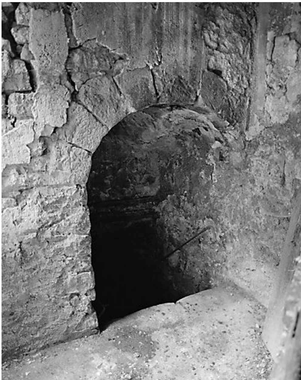
Entrée de la cave, dans l'angle nord-est de la cour.
