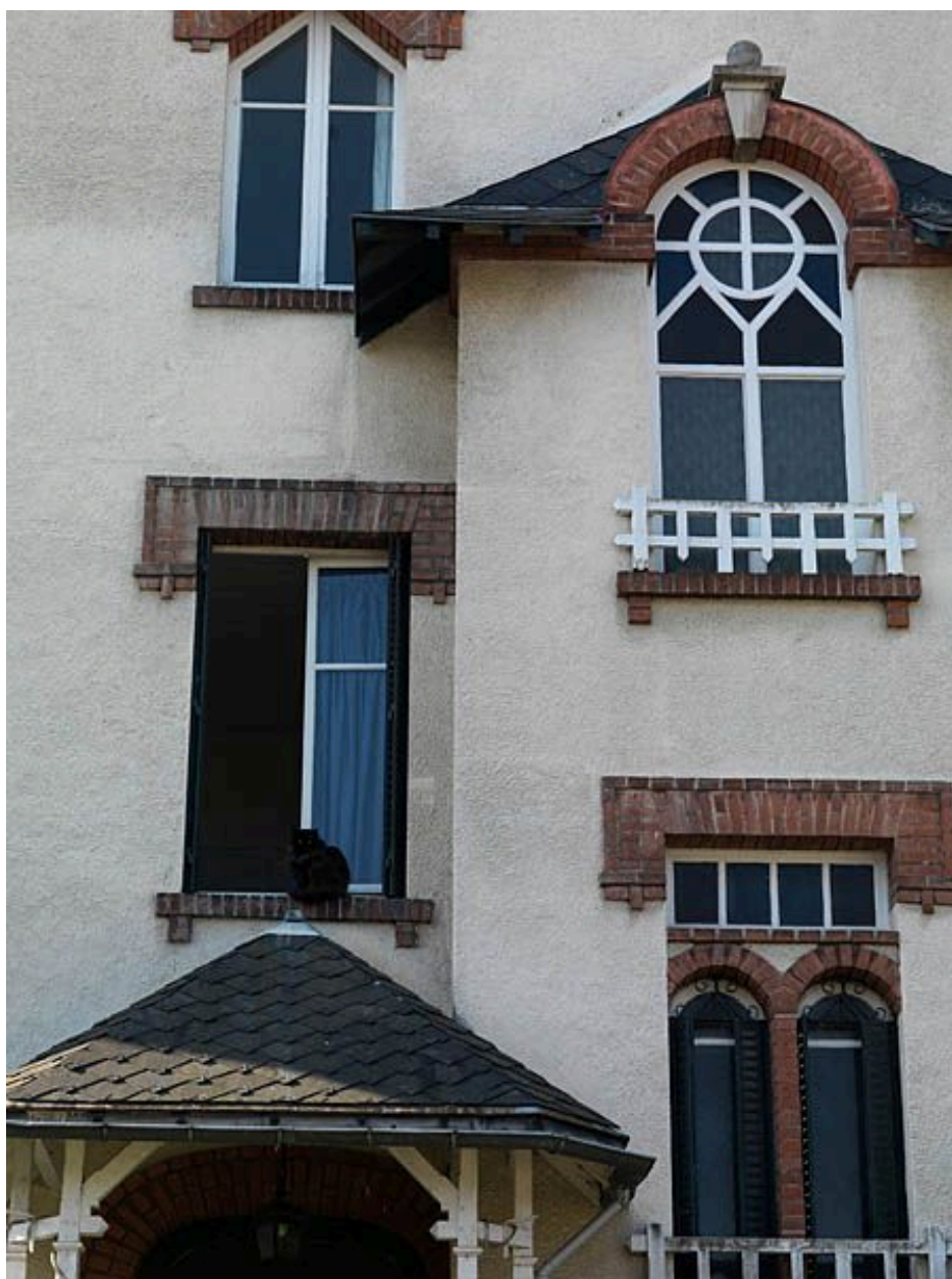
Détail des fenêtres du mur pignon nord.
