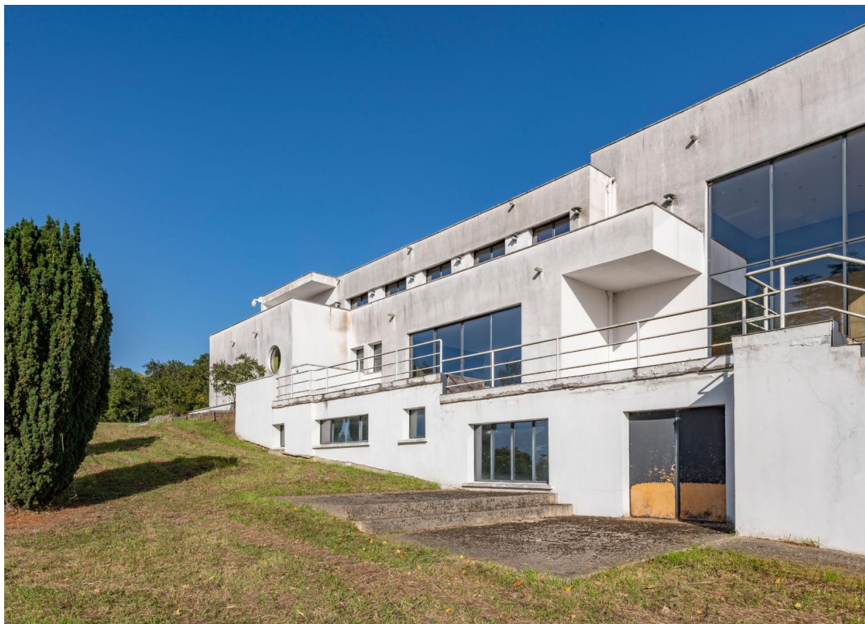
Villa Poiret, façade sud
