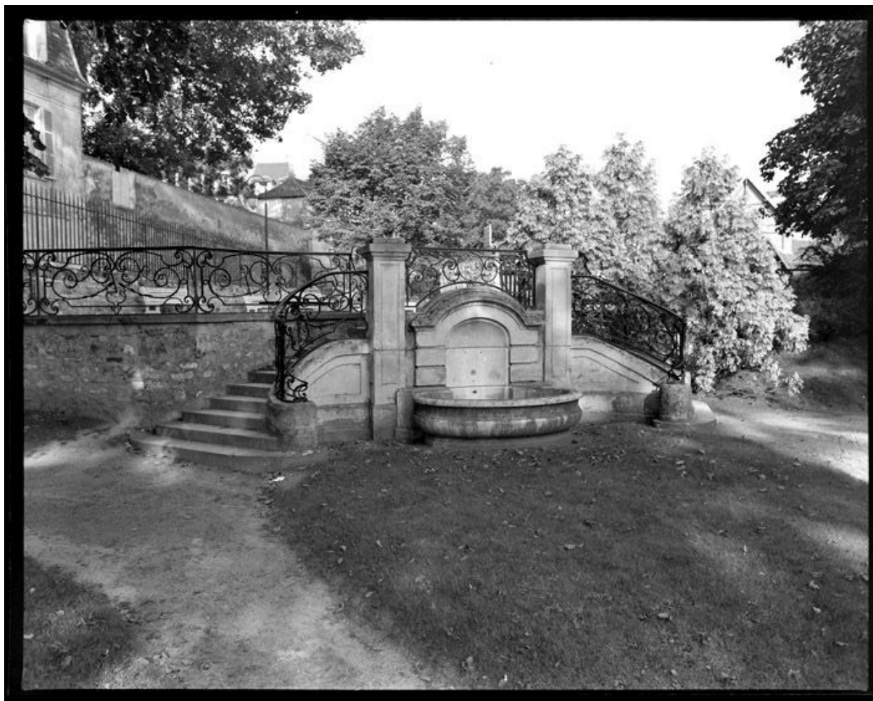
Vue de face de l'escalier extérieur.
