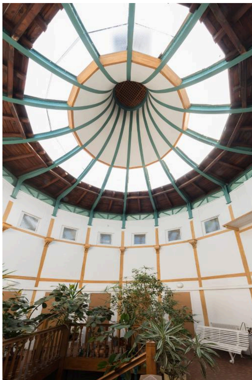
Vue de la charpente métallique de la Rotonde
