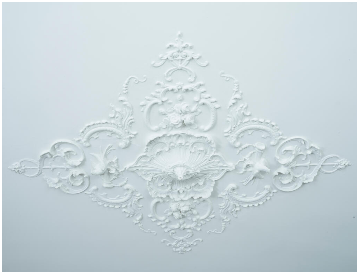
Moulure centrale du plafond de la pièce nord-ouest du rez-de-chaussée.
