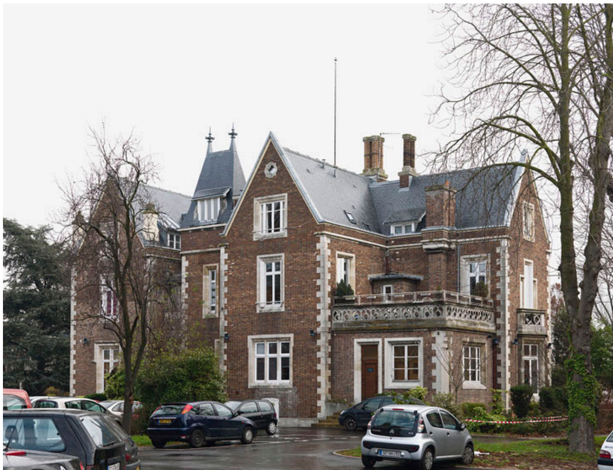
Vue d'ensemble de la façade postérieure.
