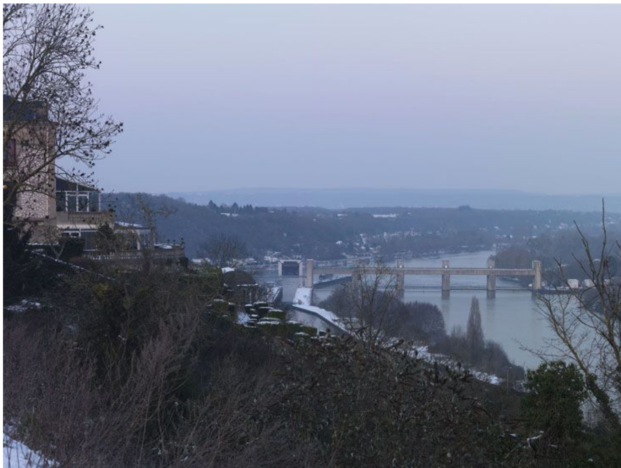
Rolleboise : vue sur le barrage éclusé de Méricourt.
