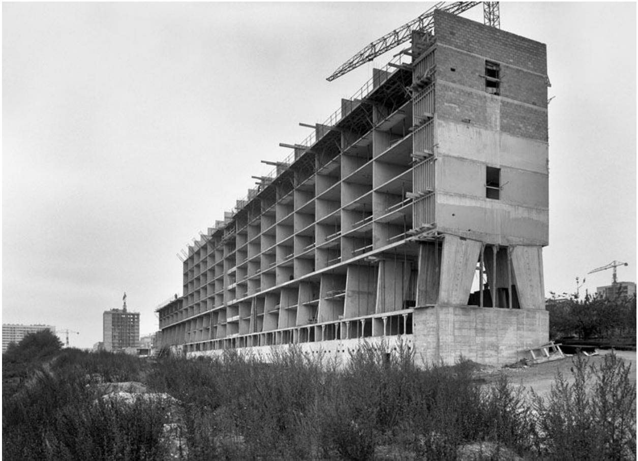
Vue du chantier de construction des barres G et H. Photographie, 1961. (Ministère de l'Écologie, MRU 38113001)
