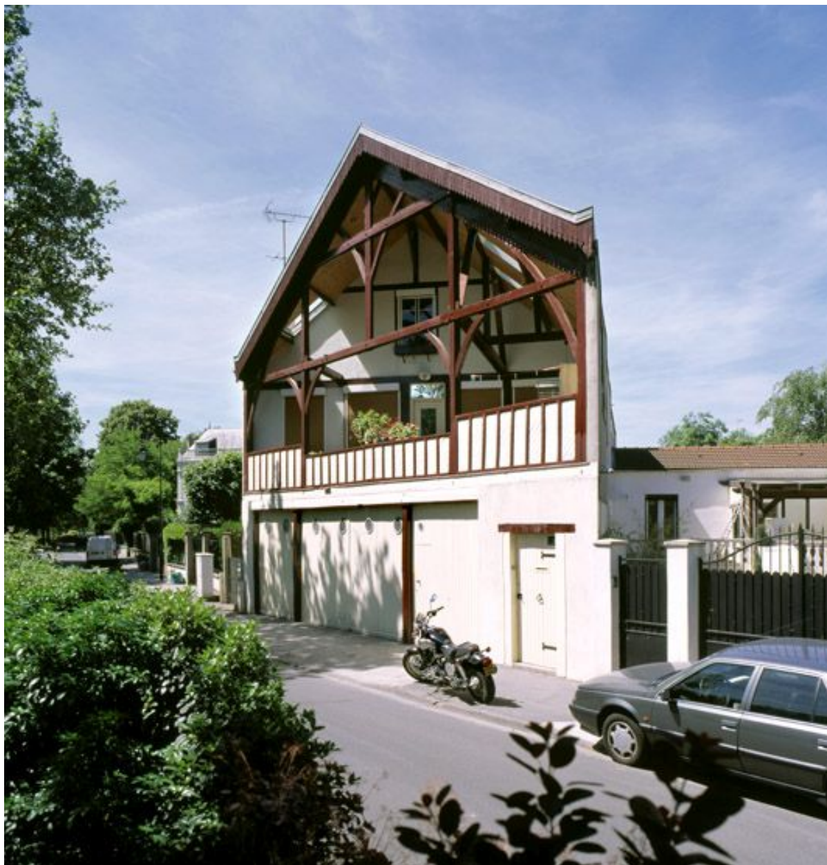
Vue frontale d'une remise à bateau, 120 quai d'Artois.
