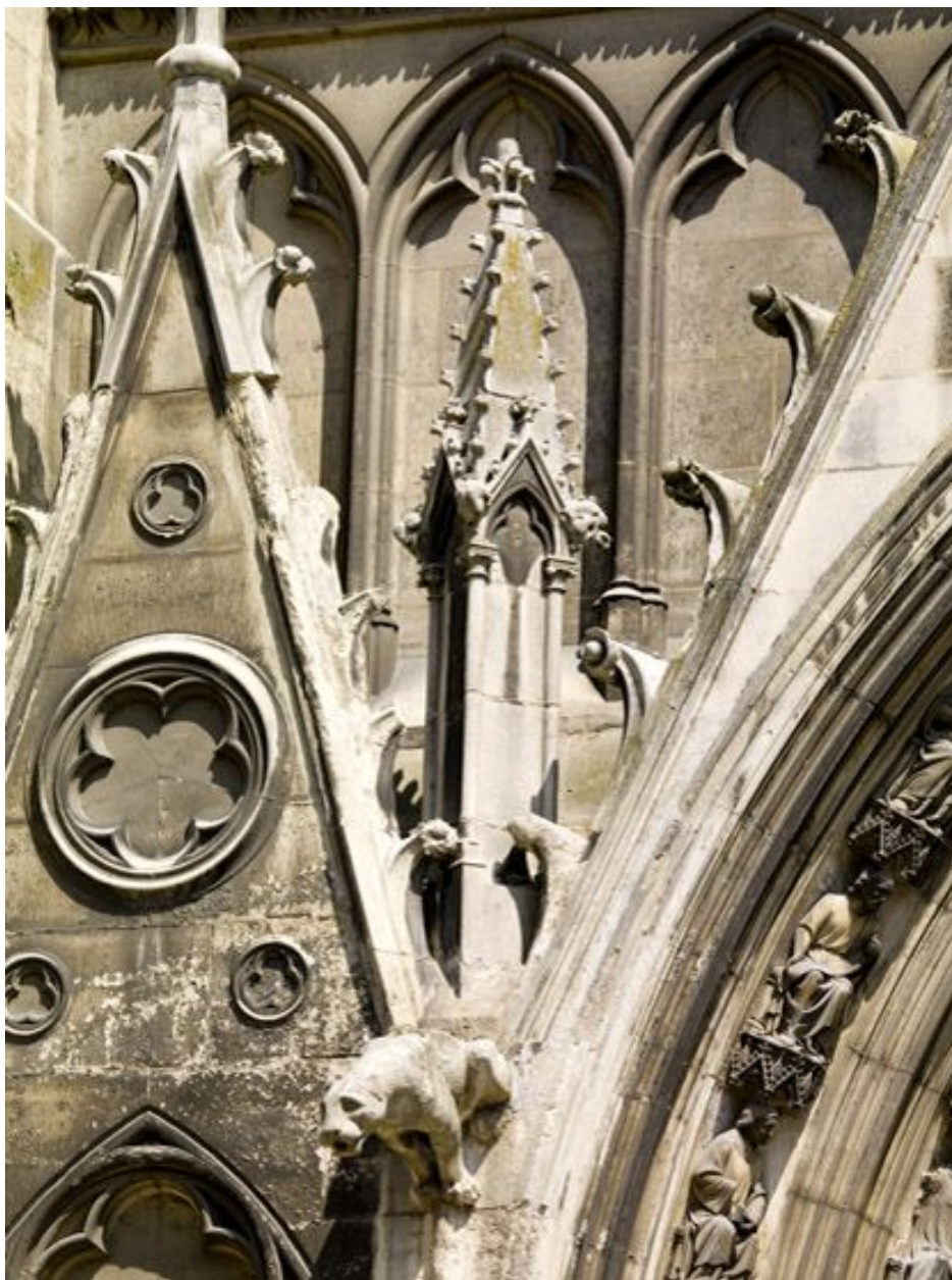
Détail du décor du portail : voissures et sommet du gâble latéral gauche.
