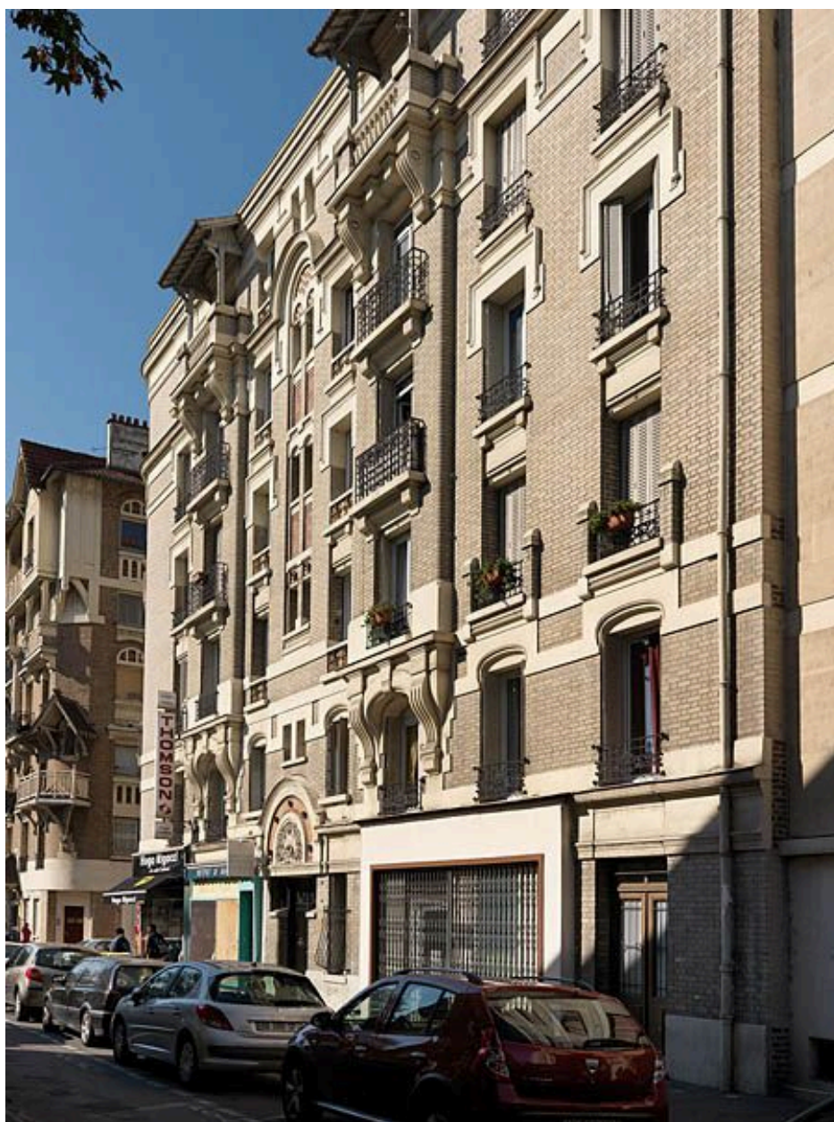
Villeneuve-Saint-Georges, immeuble, 33 rue Henri Janin . Vue générale de l'une des façades.
