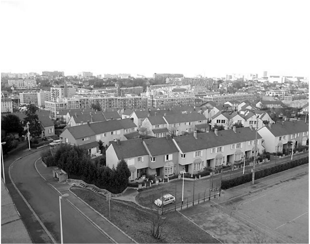
Vue de la cité jardin prise depuis le tablier du pont aqueduc de la Vanne. Cité jardin dite de l'Aqueduc
