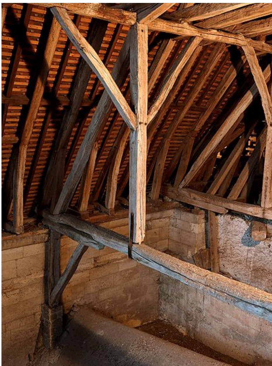
Détail de la charpente du transept.
