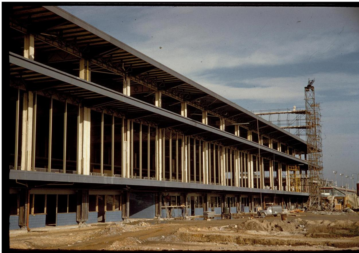
1957 1961, la construction des Installations Terminales: l'installation du mur rideau de la façade sud, vue prise depuis le sud ouest.
