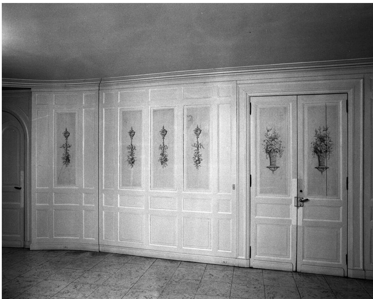
Lambris du salon blanc au rez-de-chaussée. Vue d'ensemble. La cheminée de marbre blanc qui complétait le décor a disparu lors d'une restauration.
