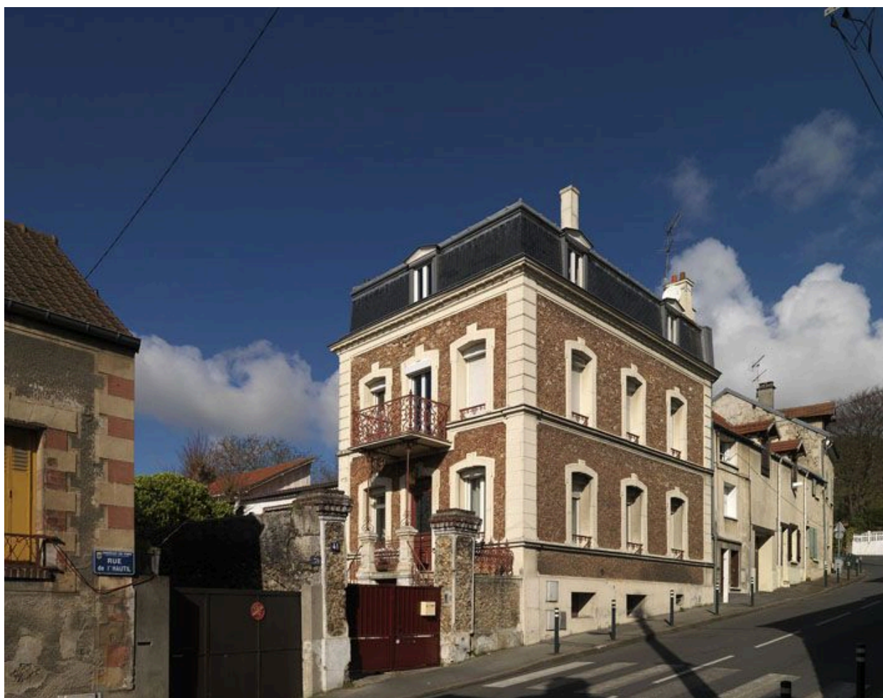
La façade principale.
