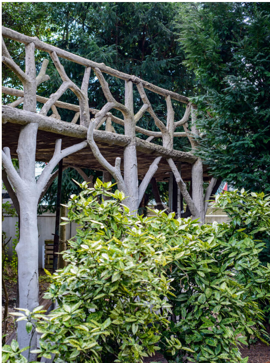
Détail du pont belvédère en béton rustiqué
