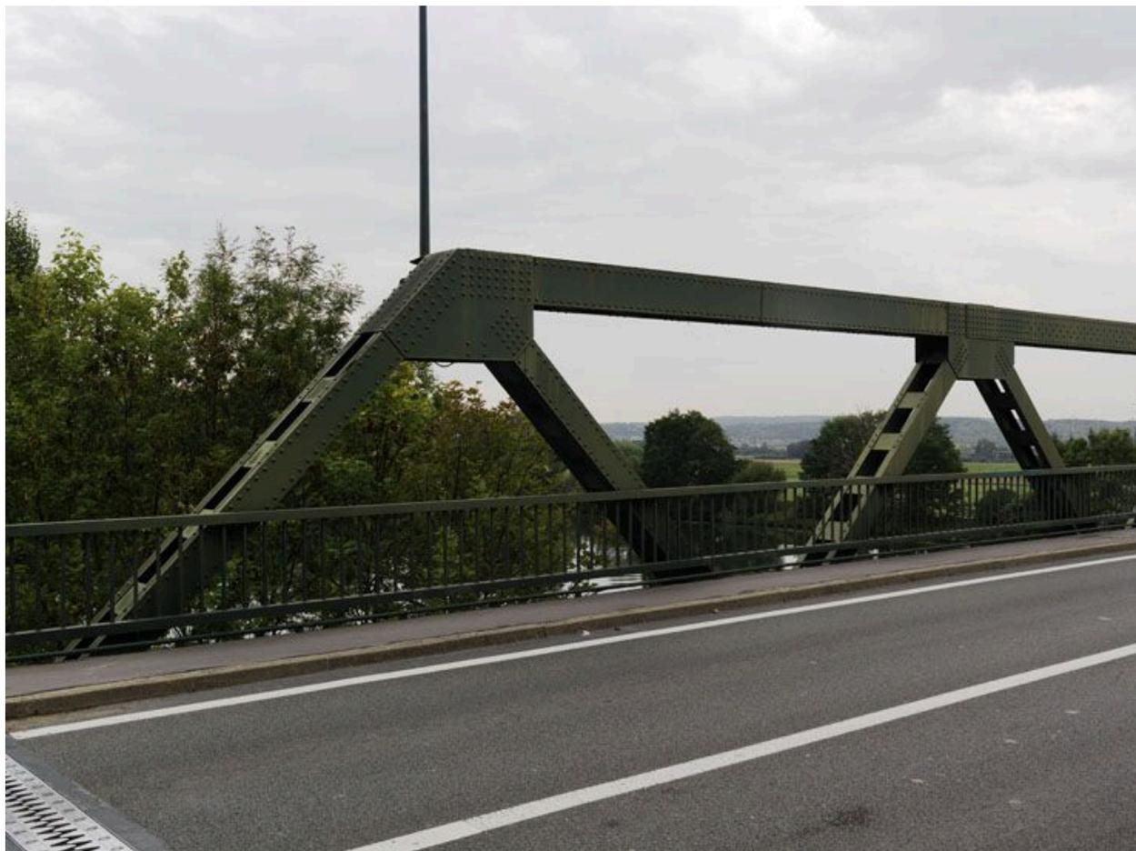
Poutres métalliques en treillis vues depuis le pont vers l'amont.
