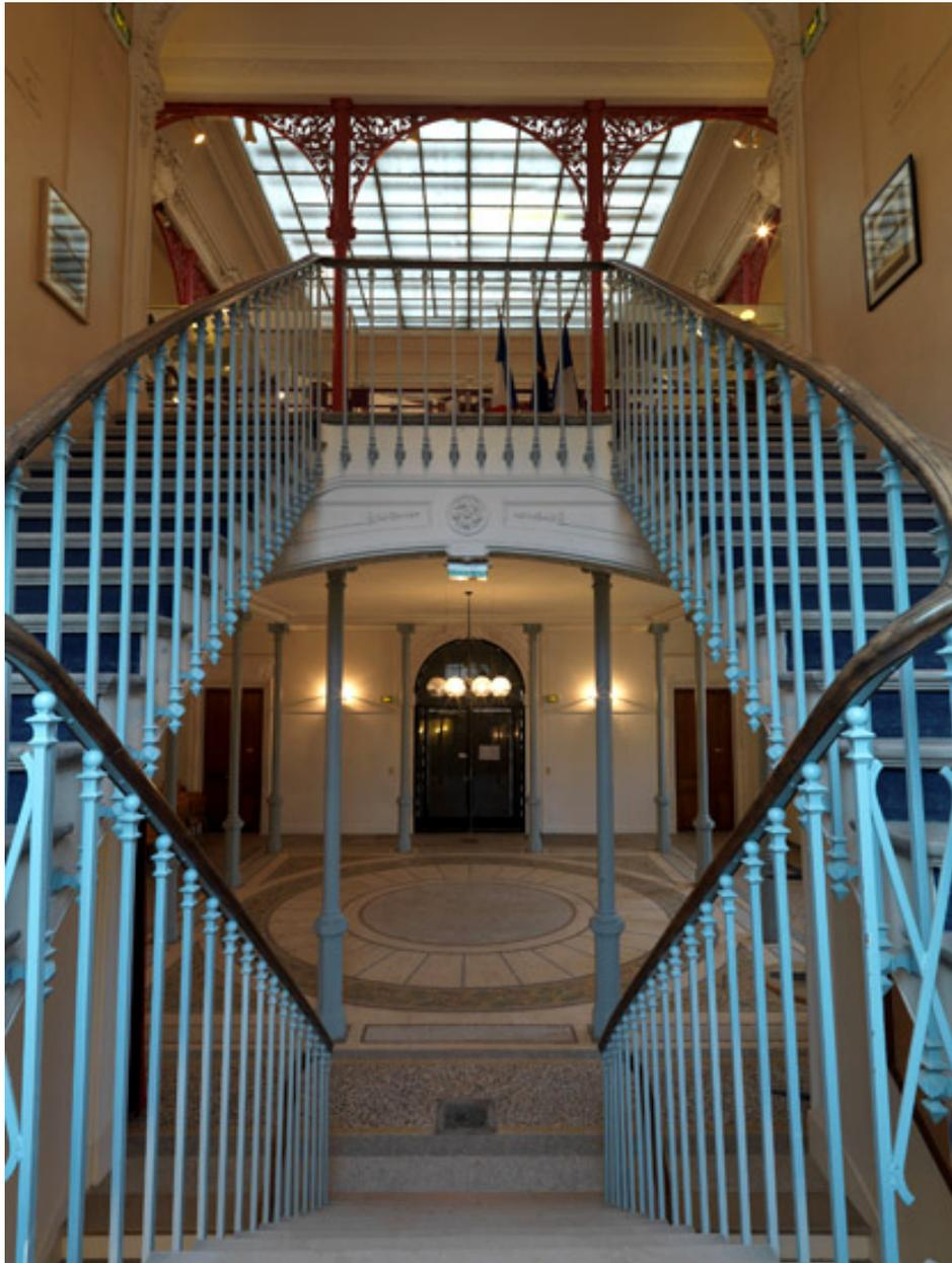
Vue de l'escalier tournant à trois volées droites. Il comporte une volée double à montées parallèles, puis une volée centrale puis une volée double à montées parallèles.
