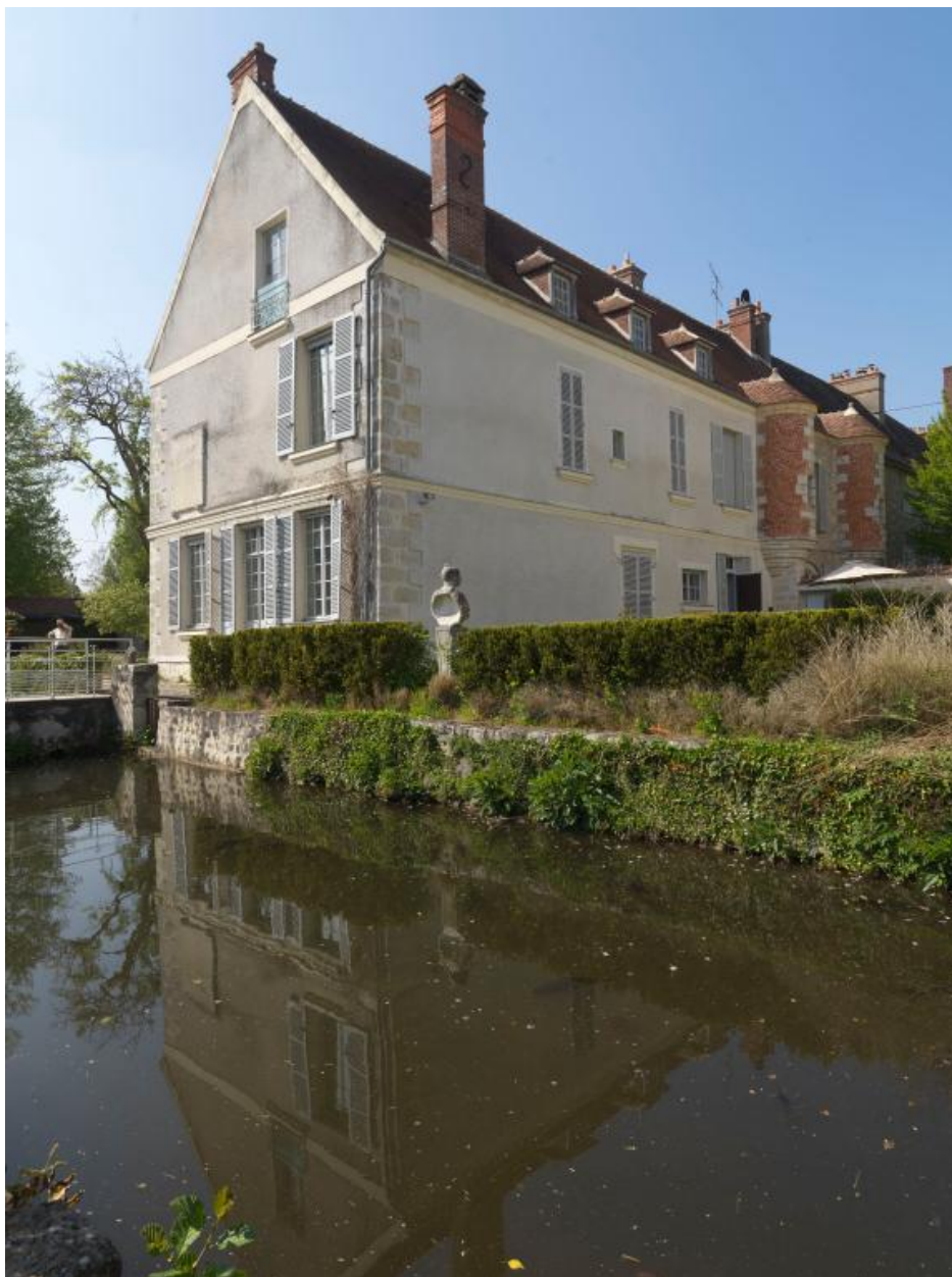
Vue du bâtiment principal prise depuis les douves du Château de la Bonde
