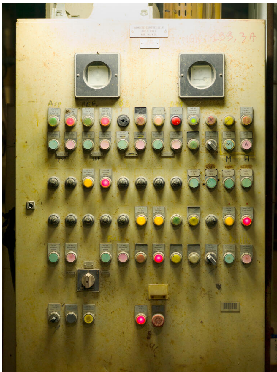
Unités Ouest - Reformeur catalytique (Unité 642). Tableau de commandes du compresseur 642 K60.
