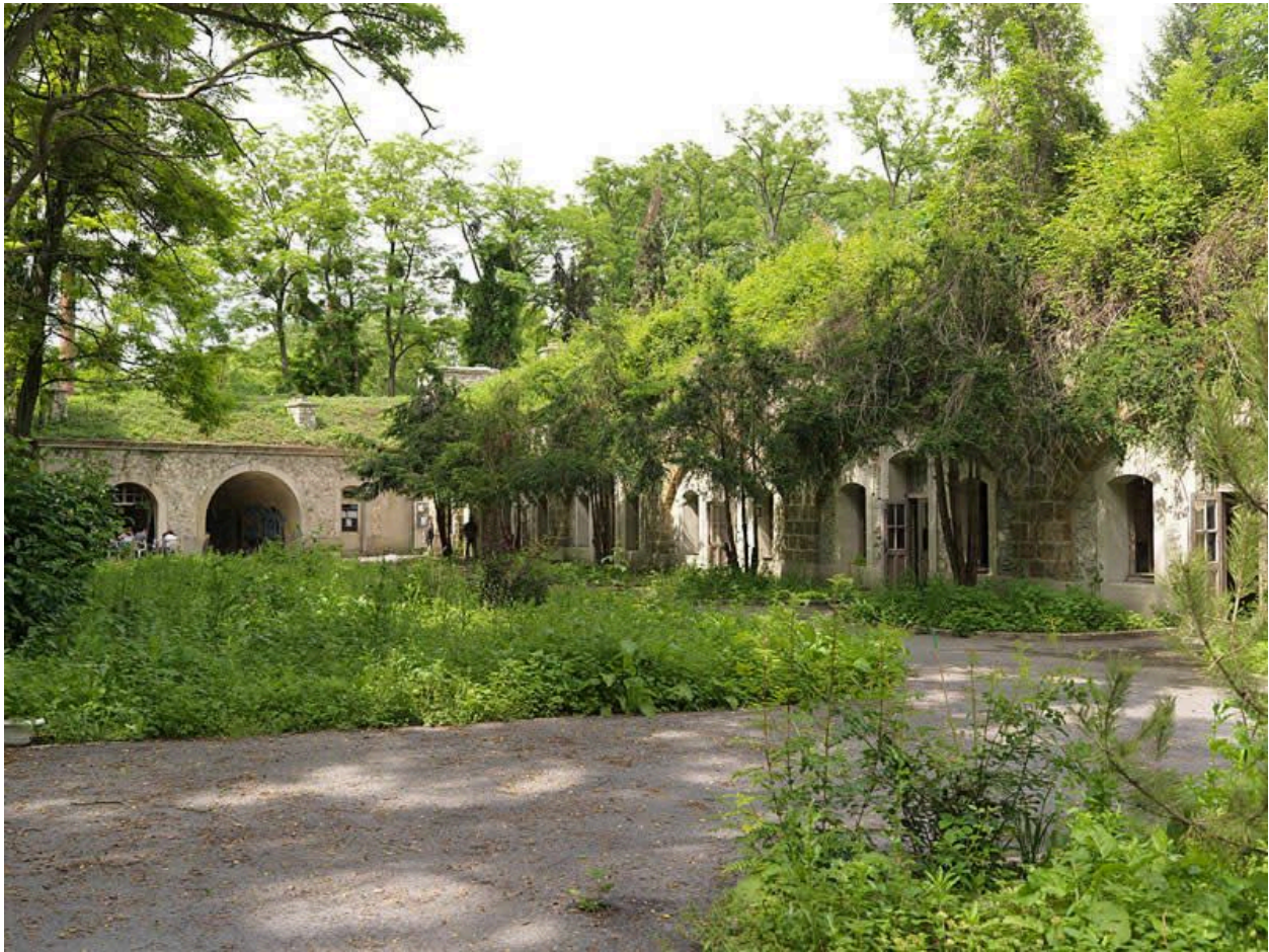
Vue générale de la partie intérieure de la batterie sud.
