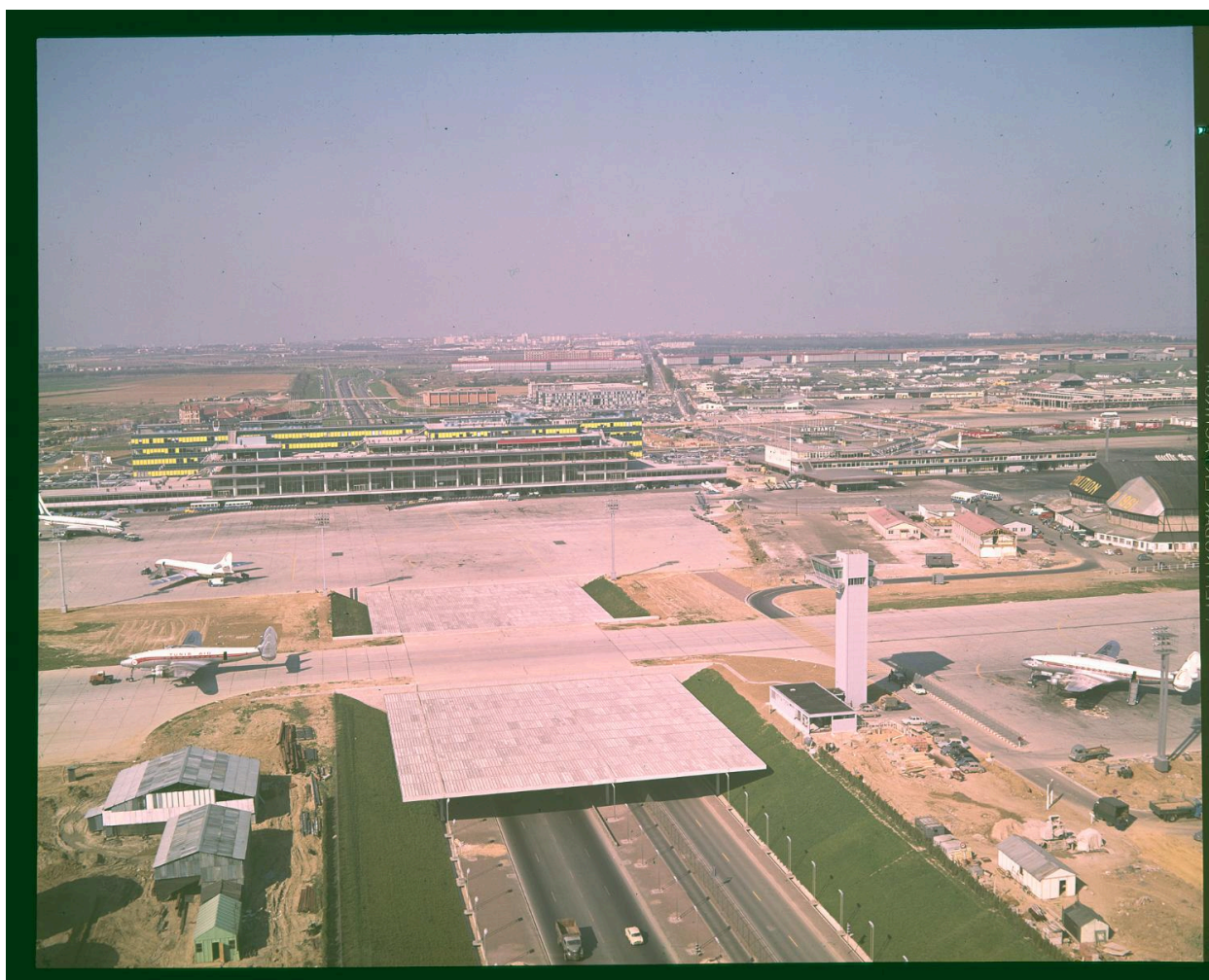
1961 février octobre, les travaux de jonction des Installations Terminales et de l'Aérogare-Sud, vus depuis le sud.
