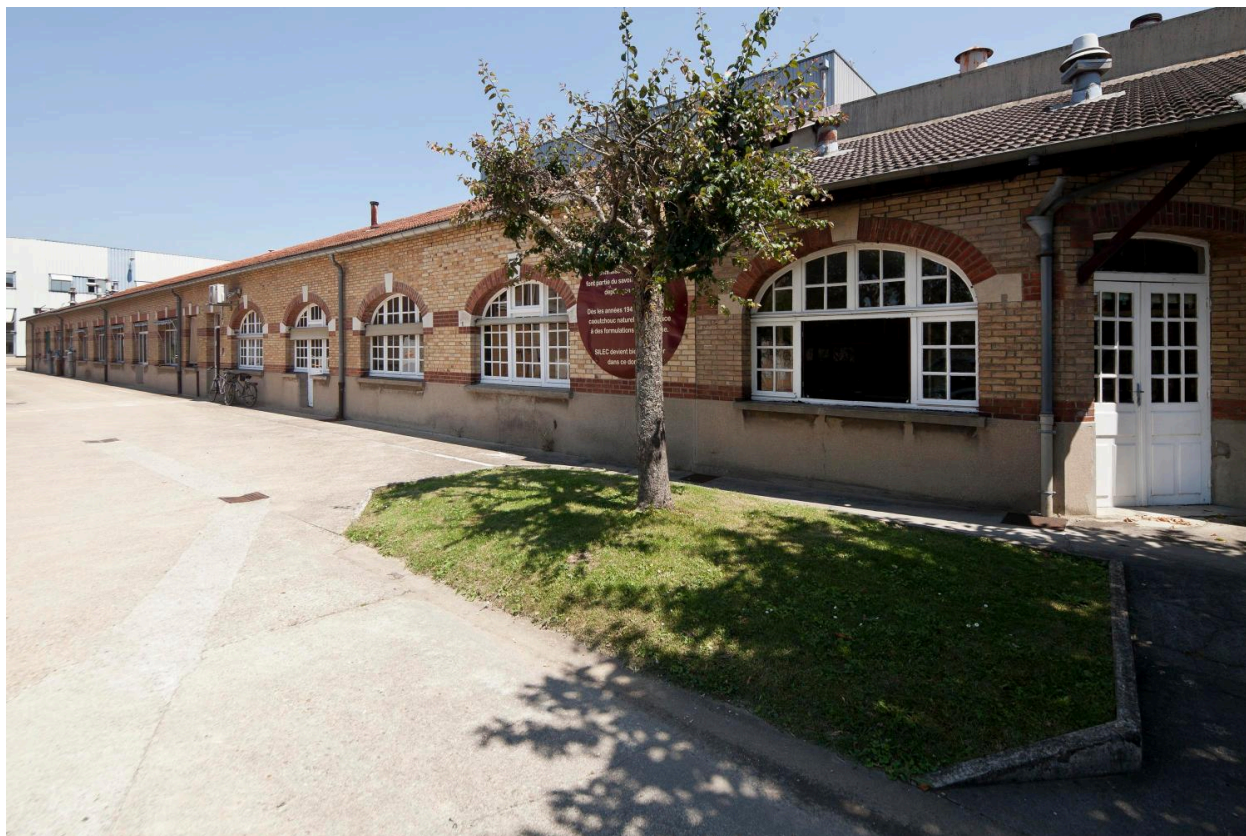
Bâtiment Z, Laboratoire, avant 1934 pour le côté rue Varennes-Prolongée puis extension dans les années 1950. (réf. Département de Seine-et-Marne : IVD77_2013_77_00309_NUCA)
