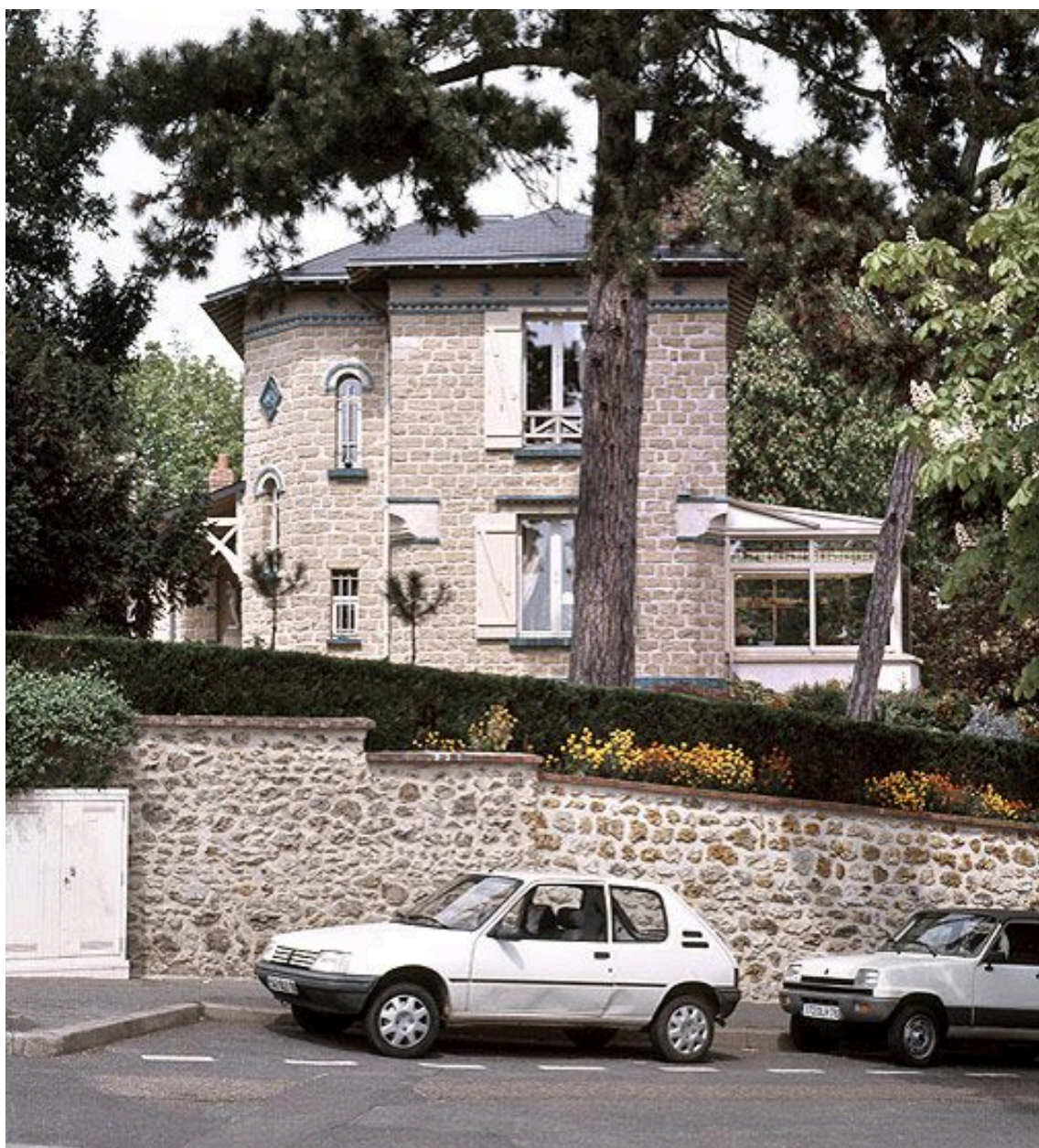
Vue d'ensemble de la façade panoramique.
