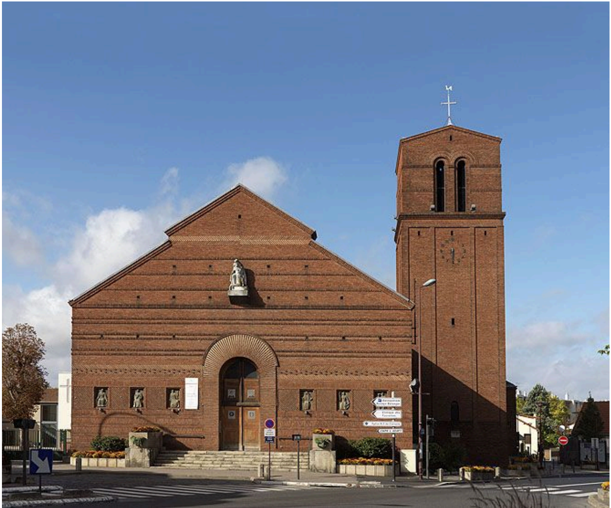
92, Châtillon, église Notre-Dame du Calvaire, 2 avenue de la Paix. Elévation de la façade antérieure.
