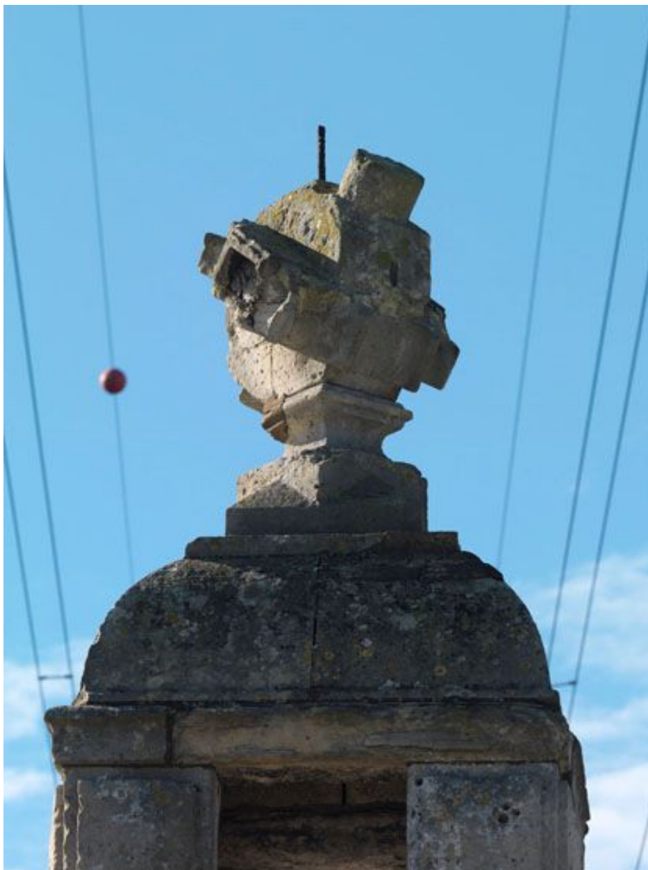
Fresnes, Chemin des Otages (rond-point du). Vue sur l'acrotère en forme de cadran solaire ou bloc gnomonique du regard III : face nord.
