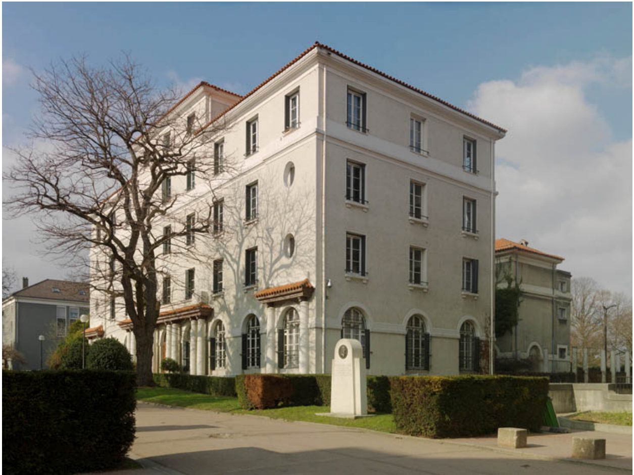
Vue d'ensemble du pavillon principal (prise du sud-est).
