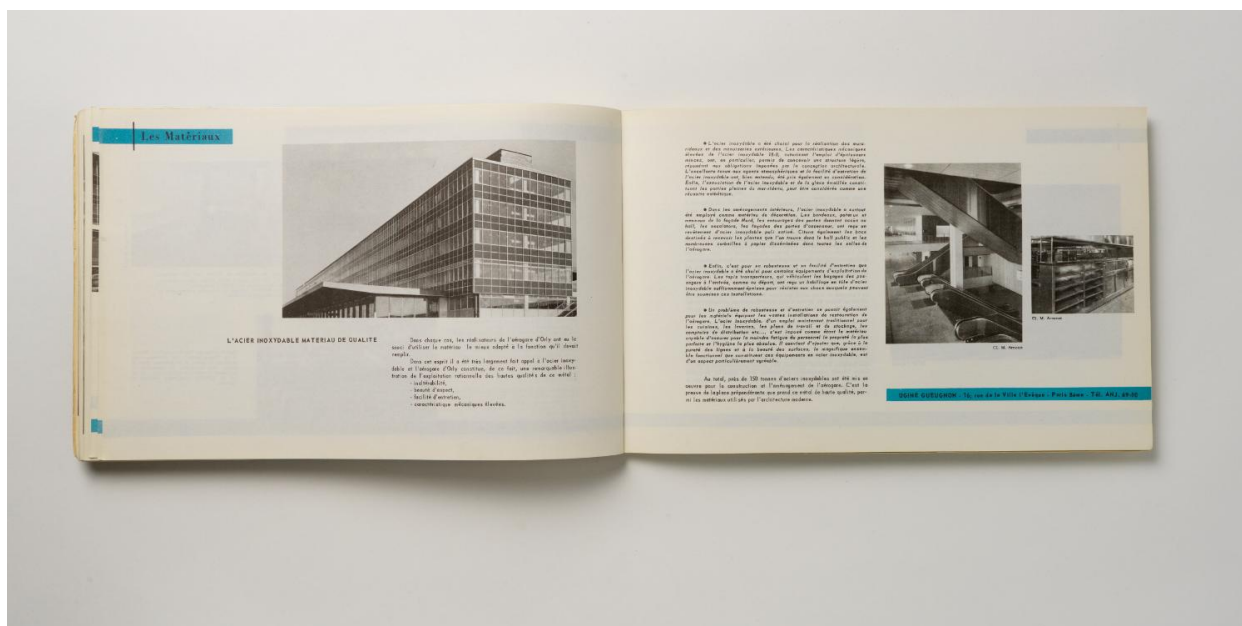
Les matériaux, "Installations Terminales Orly", brochure éditée par l'Aéroport de Paris, 1961.
