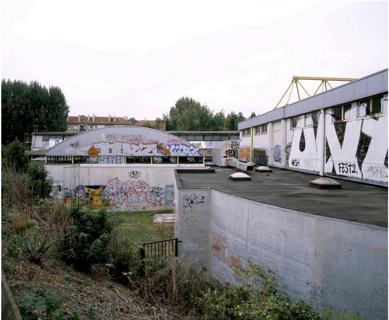
Vue du flanc est du gymnase
