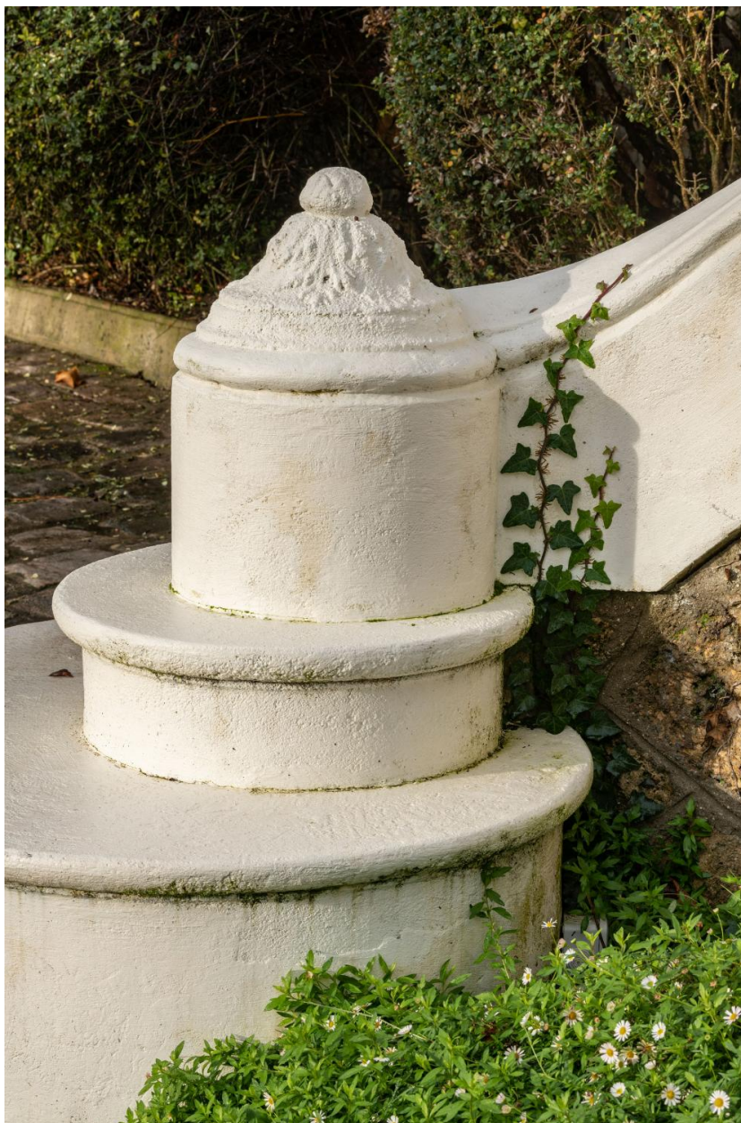
Villa les Rochettes, détail du départ d'escalier
