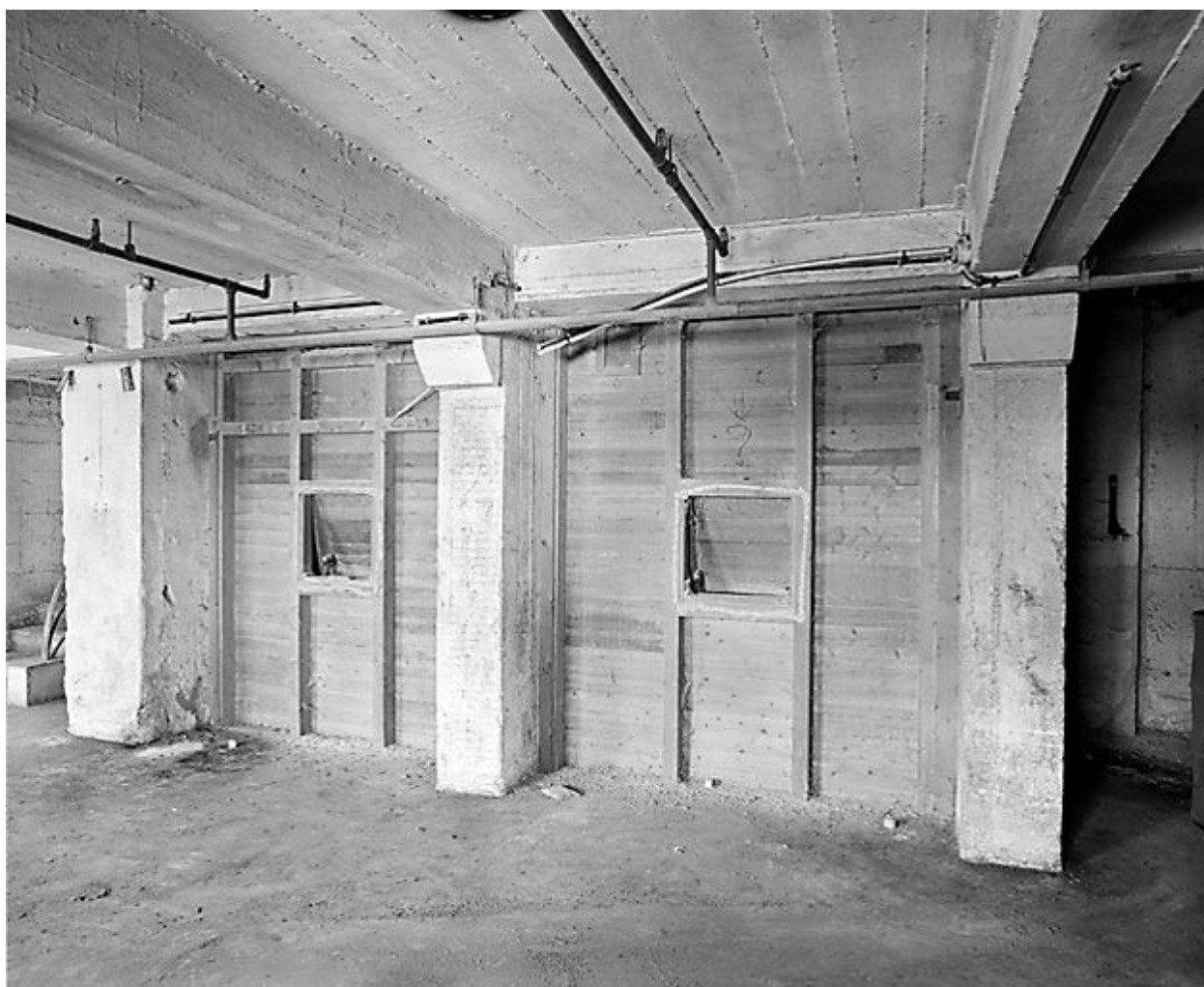
Partie magasin à farine. Au 2e étage du magasin, parois en bois des chambres à farine.
