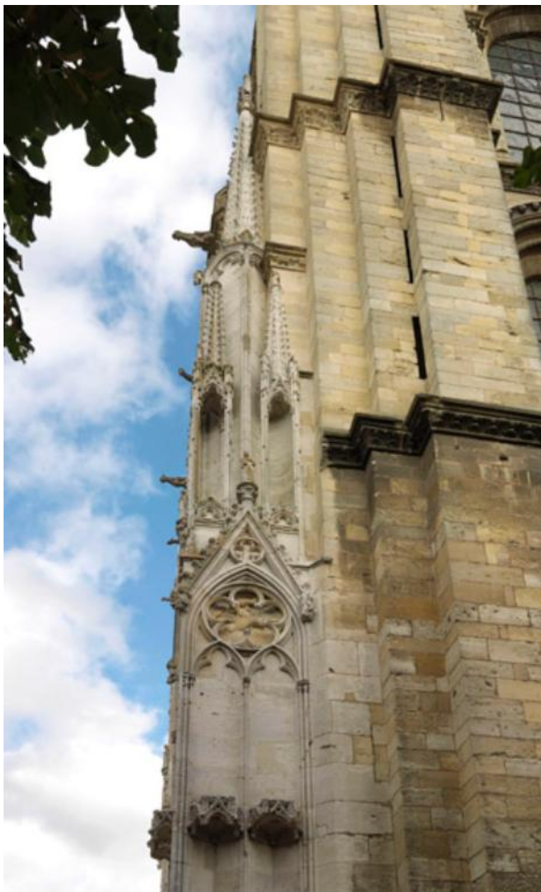
Décor latéral du contrefort sud.
