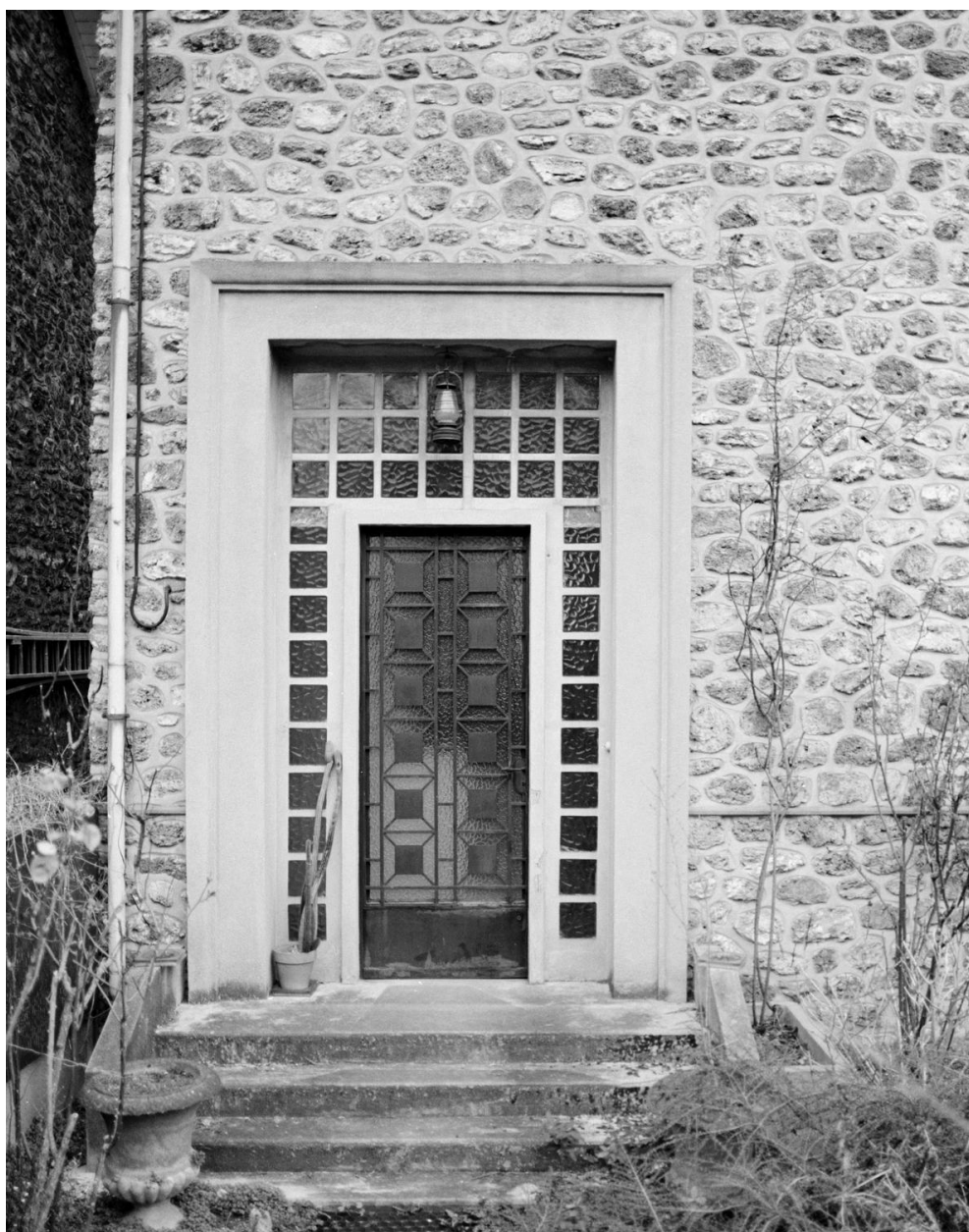
Porte d'entrée encadrée de claustra du pavillon situé 66, avenue Jean-Jaurès.
