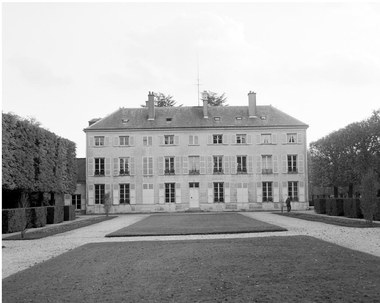
Communs. Le pavillon de l'Intendance. Château de Sceaux
