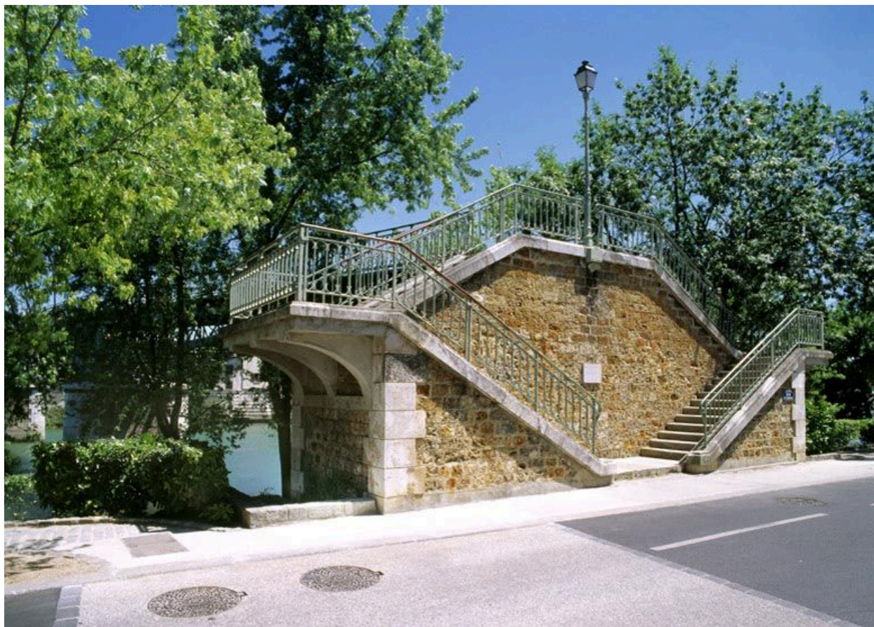
Passerelle de Bry, vue des escaliers d'accès.
