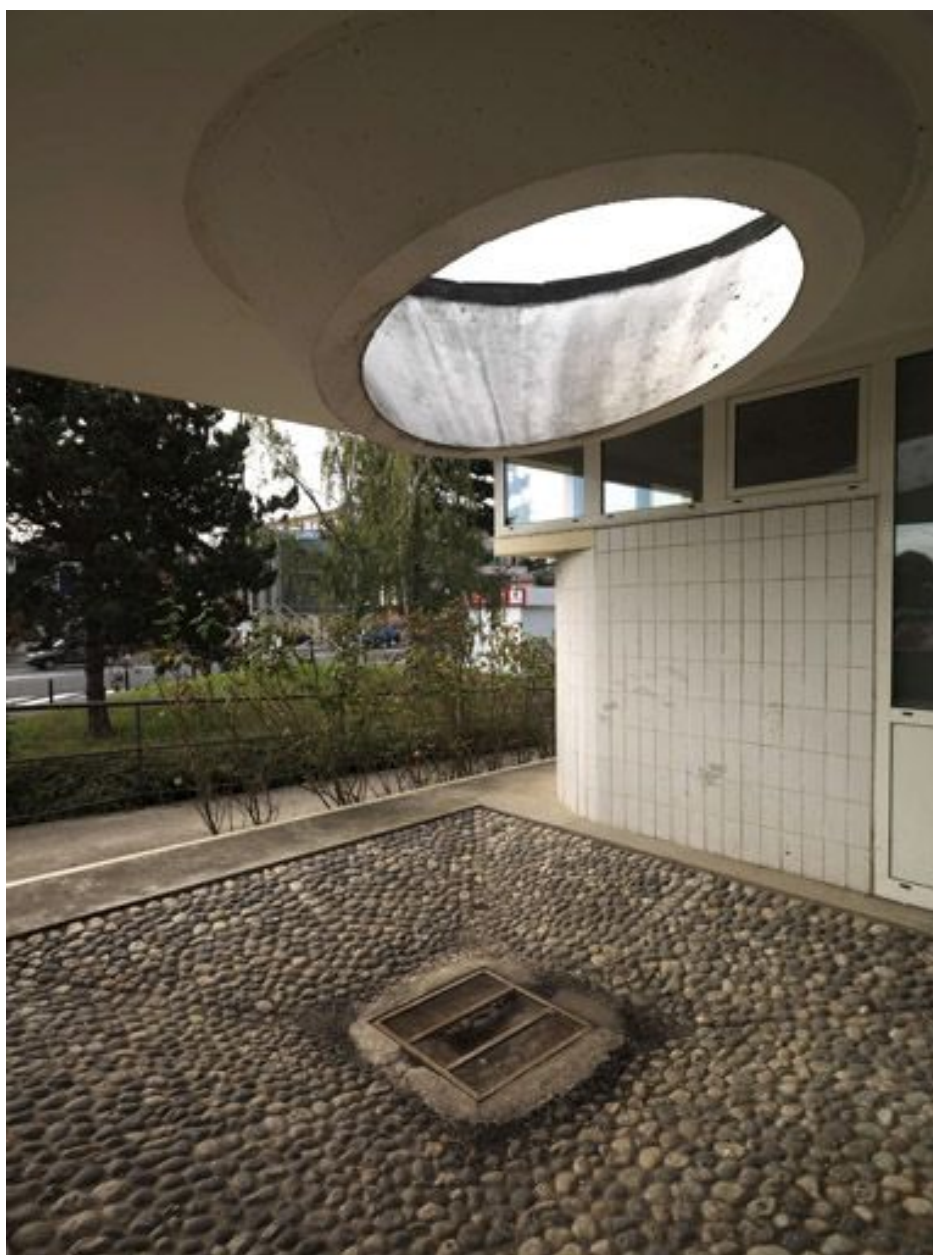
Puits de lumière percé dans la toiture.
