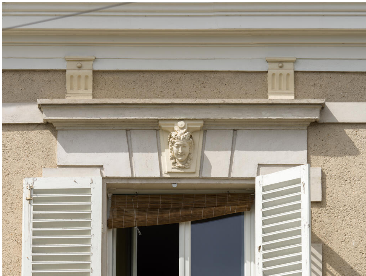
Vue de détail d'une baie de l'étage.
