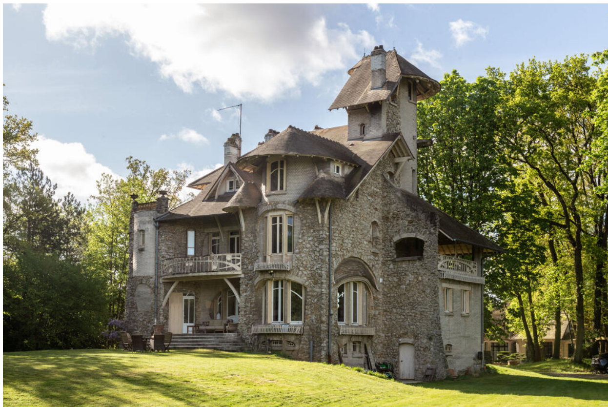
Vue des façades nord et ouest.
