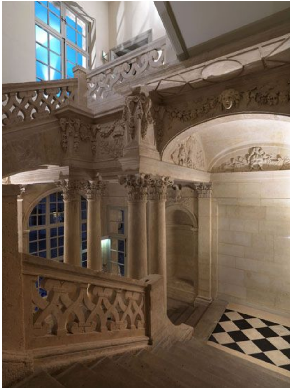
Vue d'ensemble du grand escalier en pierre.
