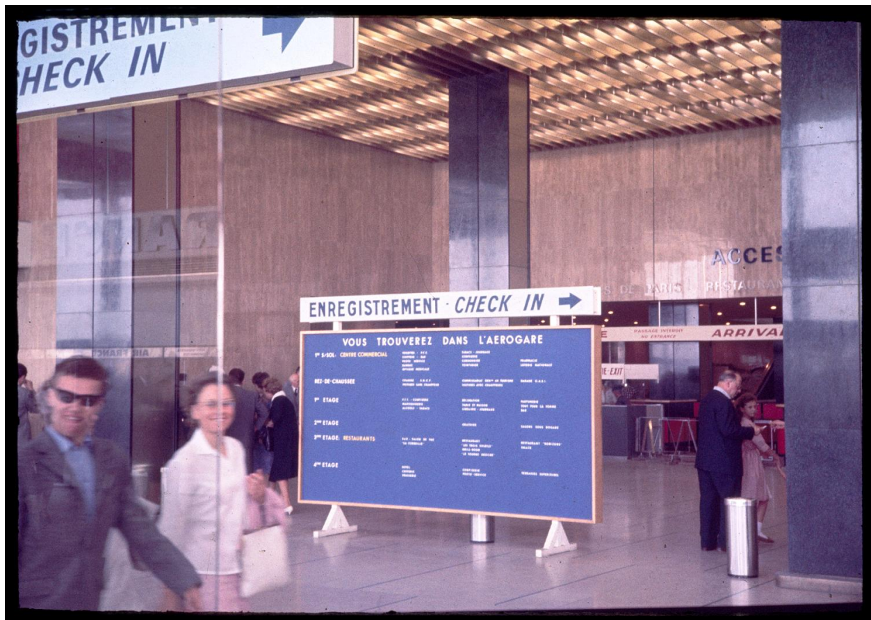
1961, le point de rencontre, rez-de-chaussée.
