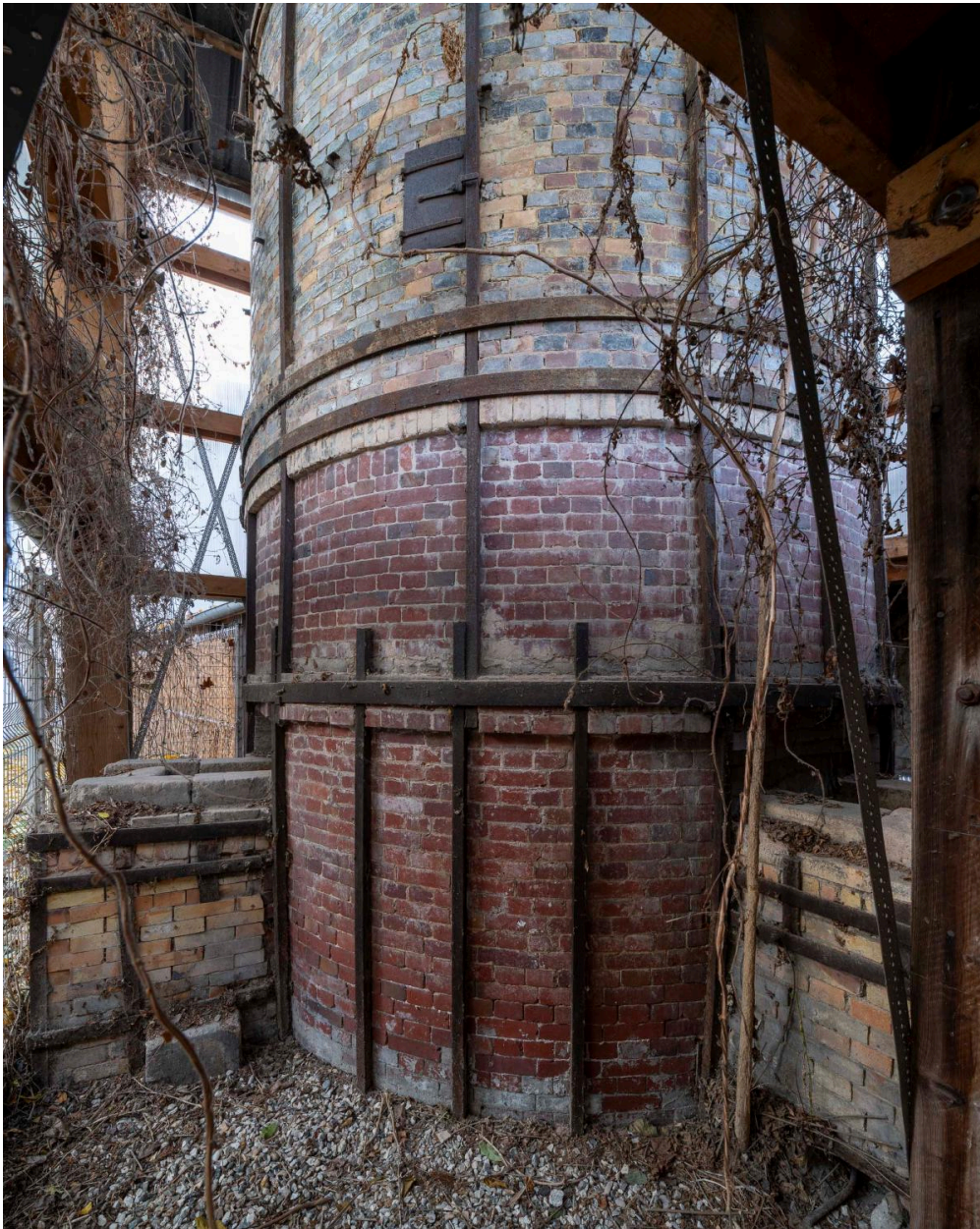
Base du four rond à globe et à flamme renversée, brevet 1878, mis en place avant 1912.
