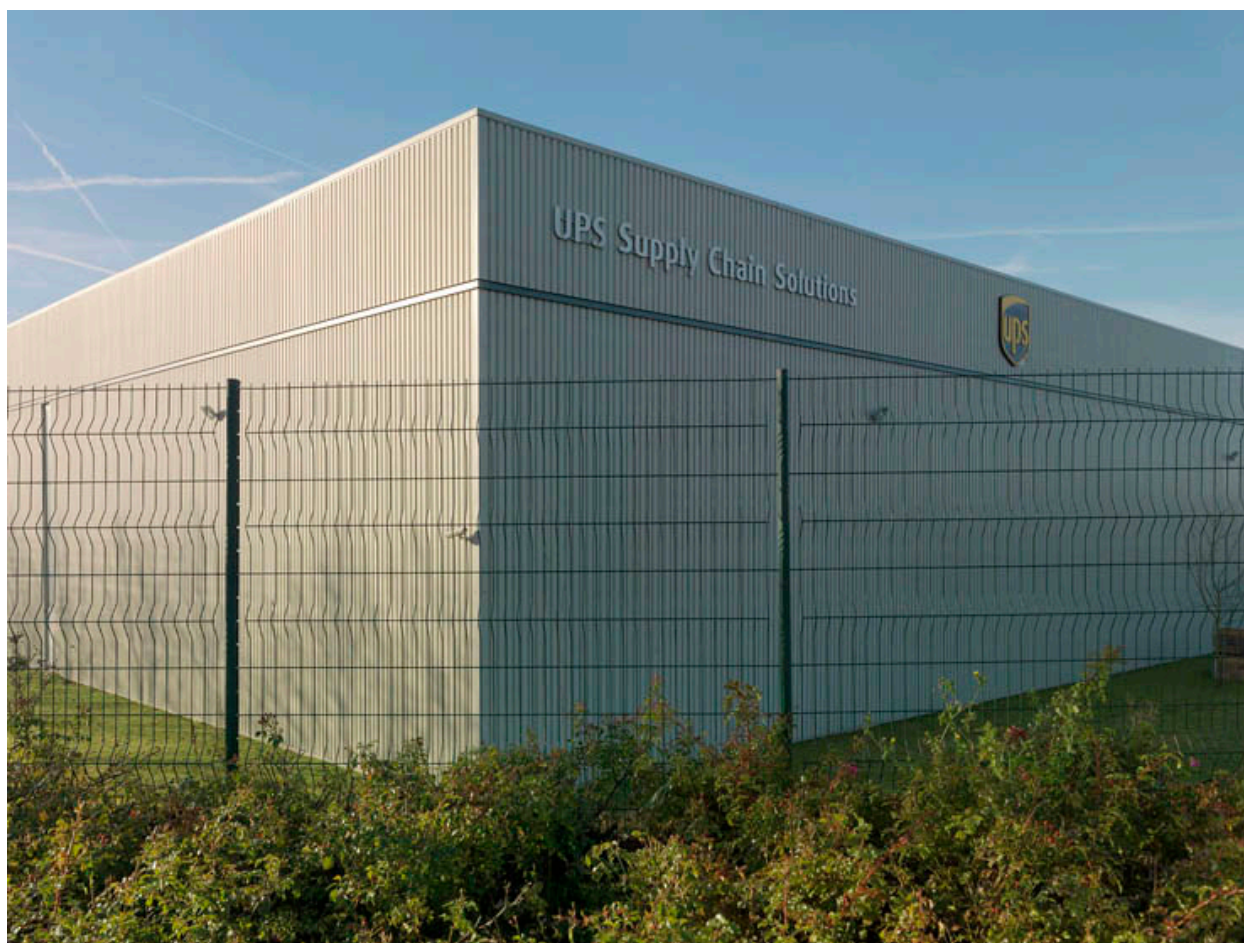
Survilliers. ZI de la Porte des Champs. Entrepôt de la société UPS.
