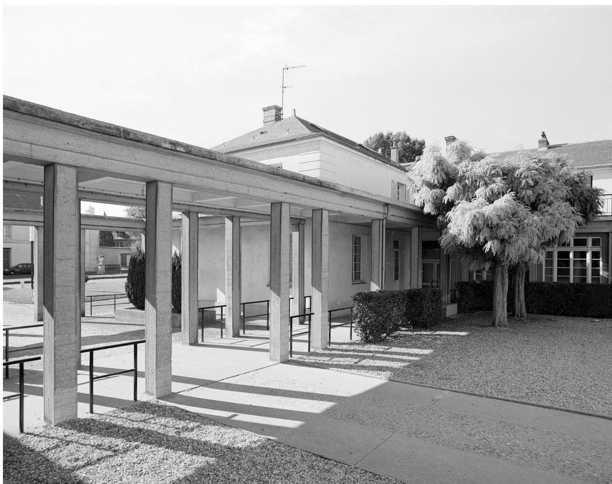
La galerie-portique vue de la cour de l'école.
