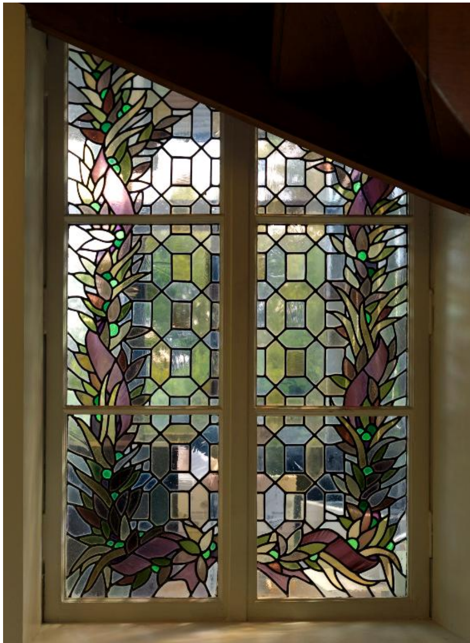
Le vitrail de la cage d'escalier.
