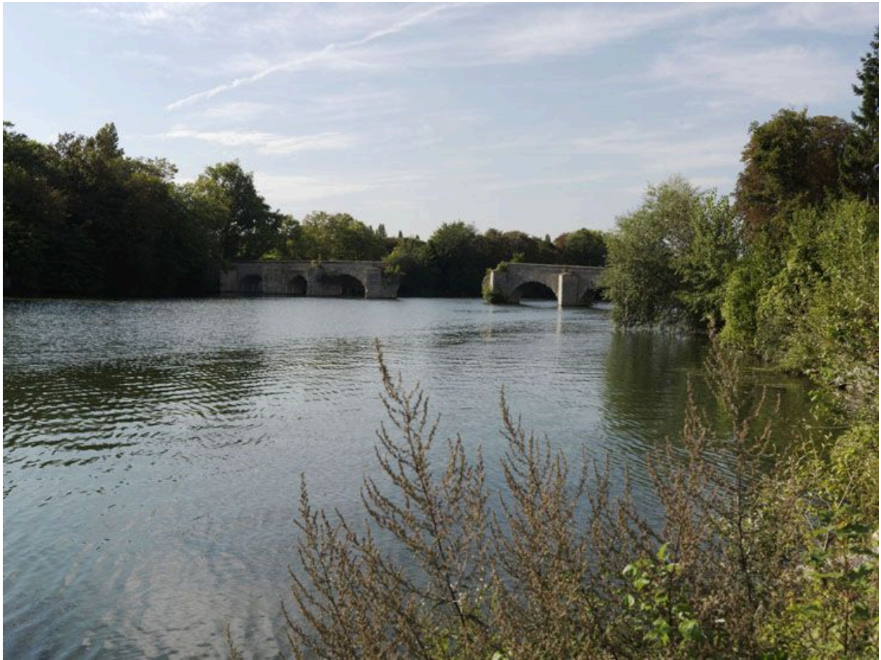
Vue du vieux pont de Limay vers l'aval depuis les quais.
