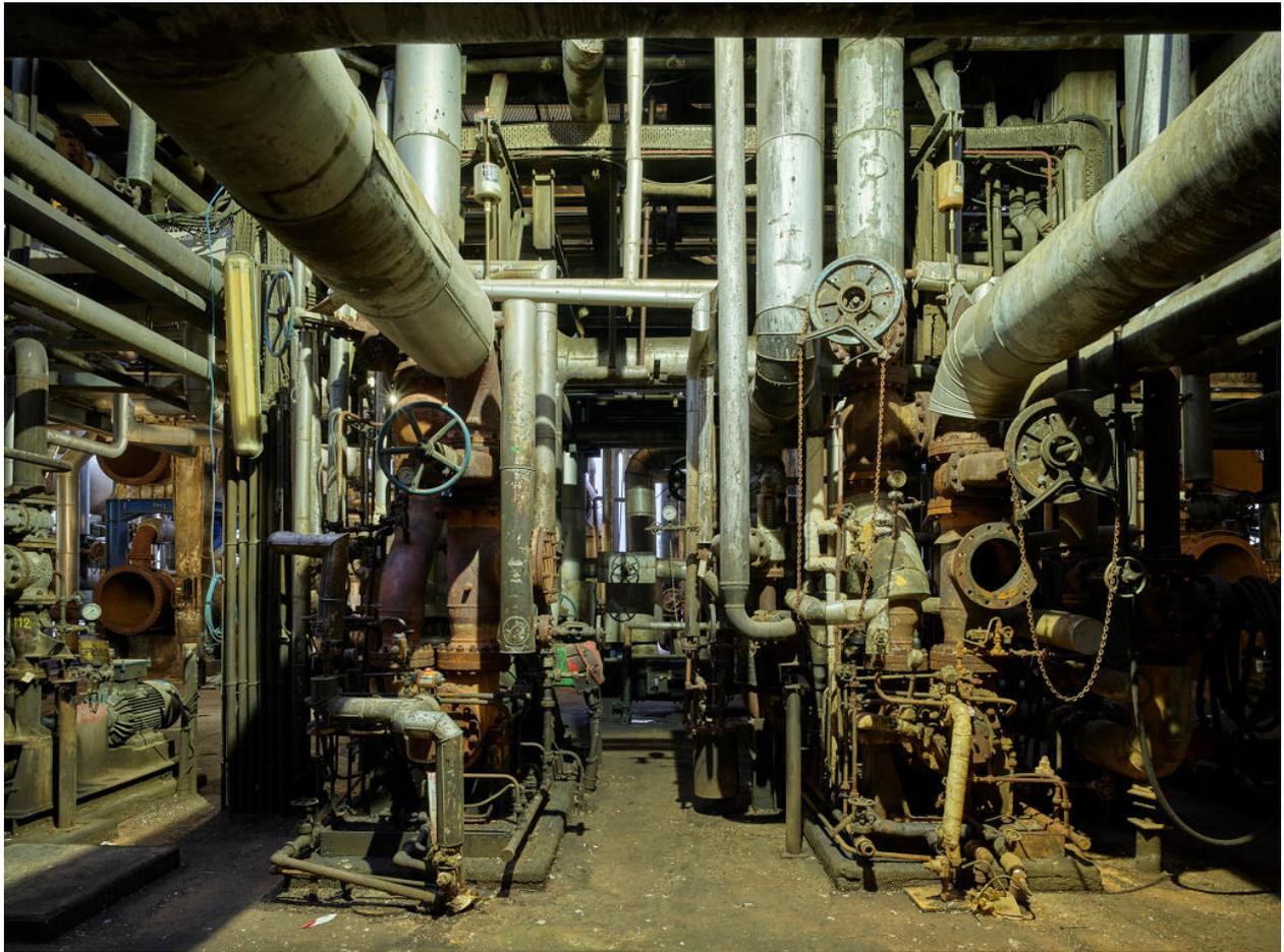
Unités Ouest - Zone de distillation (Unité 612). Cœur de l'Unité 612, au pied de la colonne 612 C1. À droite, turbopompe (GT 7), et motopompe (GM 107) à gauche. Ces deux pompes étant utilisées pour aspirer le fond de la colonne.
