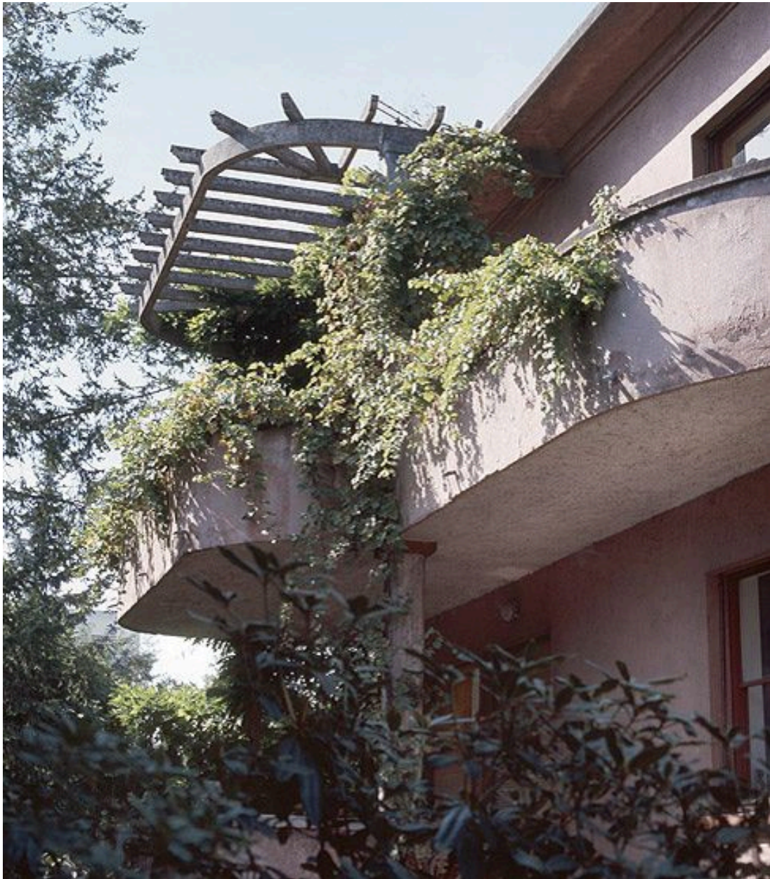
Détail du balcon de l'étage et de la pergola d'une maison, 47 rue de la Gaîté.
